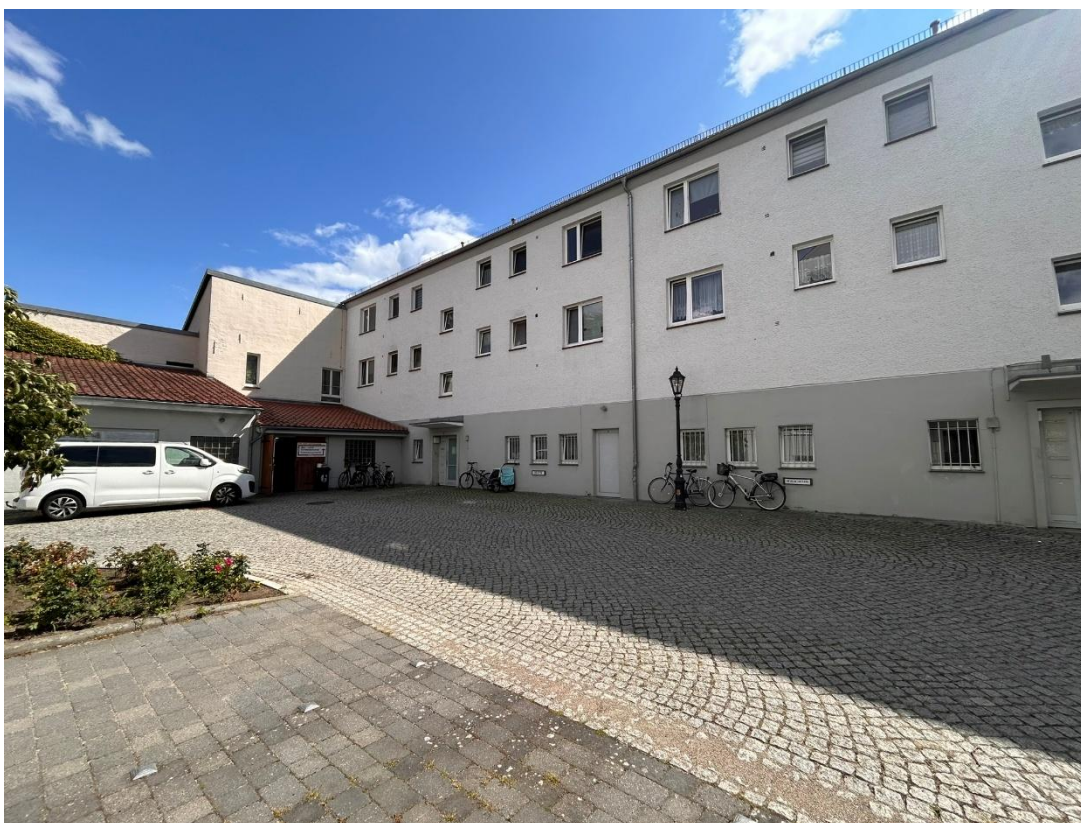
Abb. 4: Ansicht Rückseite Objekt
